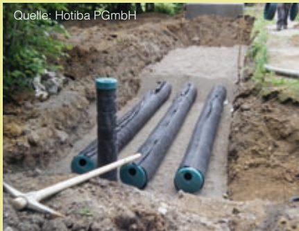
Klärrohre auf Sandbett
